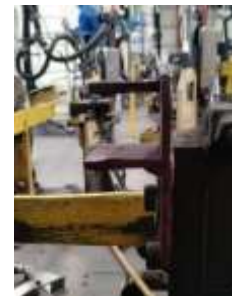
(d) Welding Gun Guide Installation
